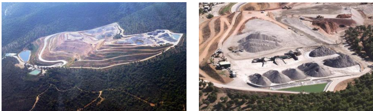
Centre d'enfouissement de Roumagayrol et plateforme de traitement des mâchefers à Pierrefeu
