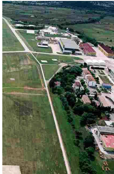
En zone sud : les installations industrielles aéronautiques
