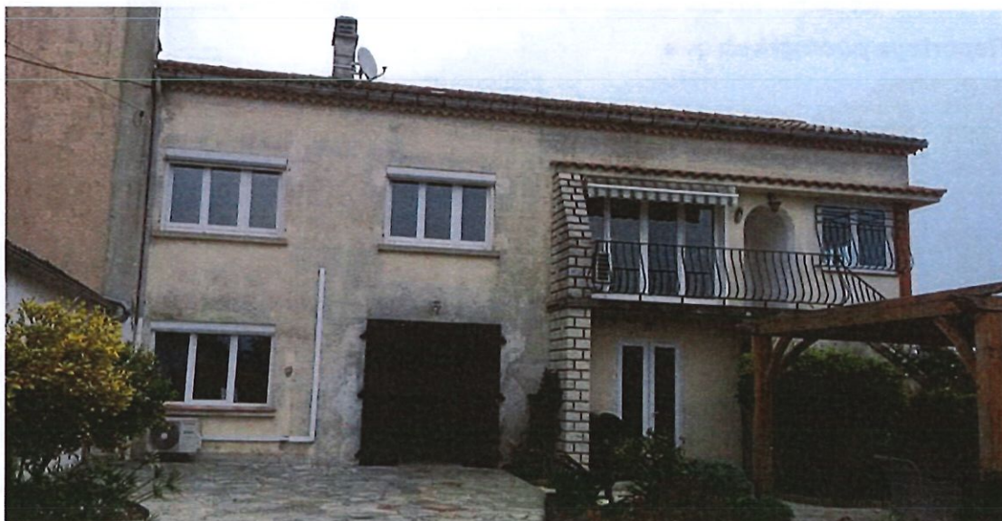
A gauche, en rez de chaussée, le bâtiment agricole. Au-dessus et à droite, la partie habitation
