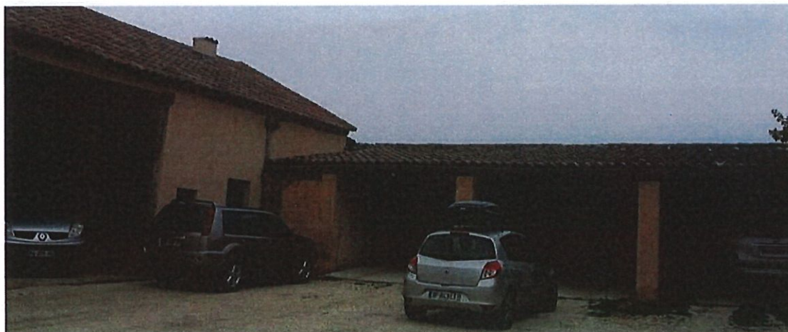
A gauche, le bâtiment agricole, à droite le garage
