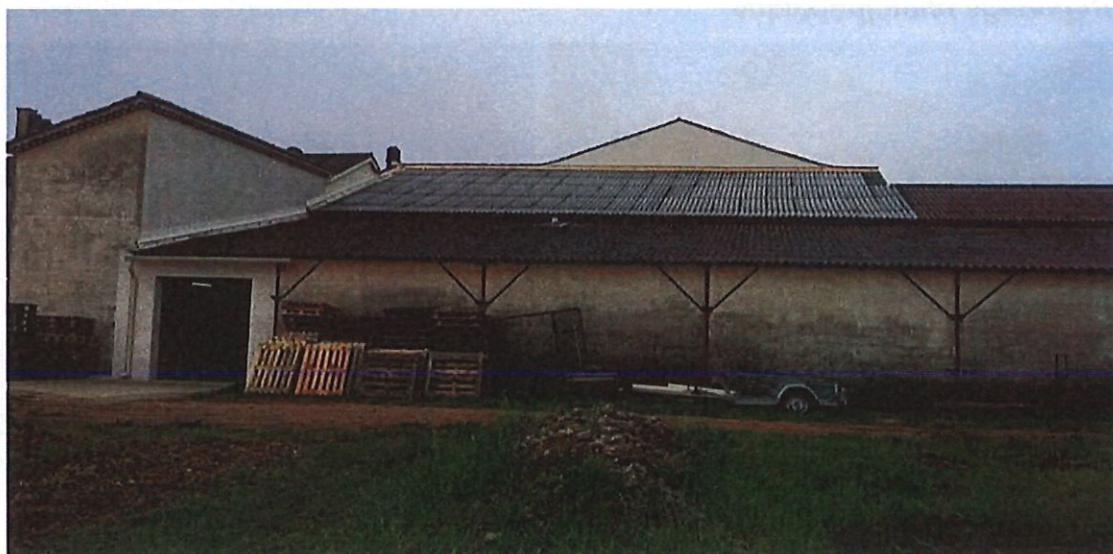
A droite, le bâtiment agricole
