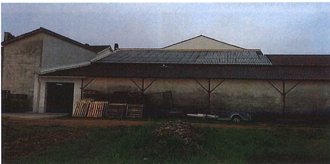
A droite, le bâtiment agricole
