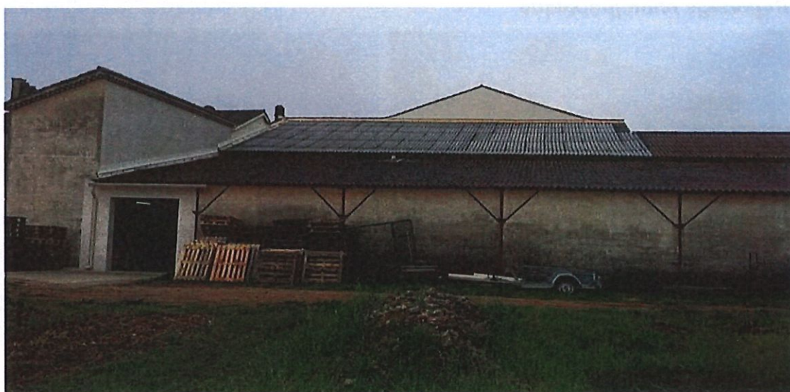
A droite, le bâtiment agricole
