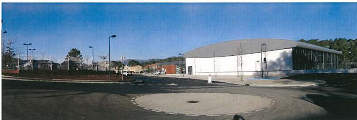
Le nouveau gymnase du Pas de la Garenne
