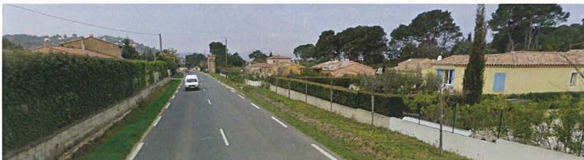
La RD14, au Nord de l'agglomération
